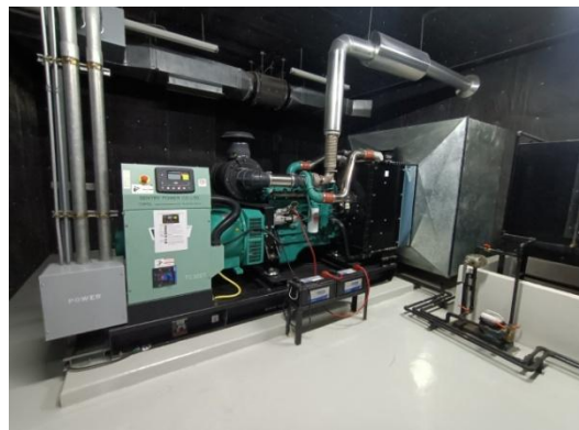
ห้องเครื่องกำเนิดไฟฟ้าสำรอง อาคาร C และ D
