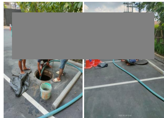
รูปที่ 2-33 การสูบน้ำและสิ่งปฏิกูลจากระบบบำบัดน้ำ เสีย
