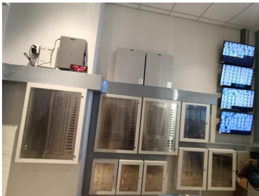
แผงควบคุม Fire Alarm
