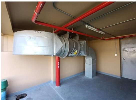
รูปที่ 2-26 ระบบระบายอากาศแบบกล
