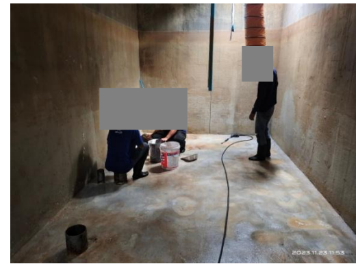
รูปที่ 2-52 การล้างถังเก็บน้ำ ประจำปี 2566
